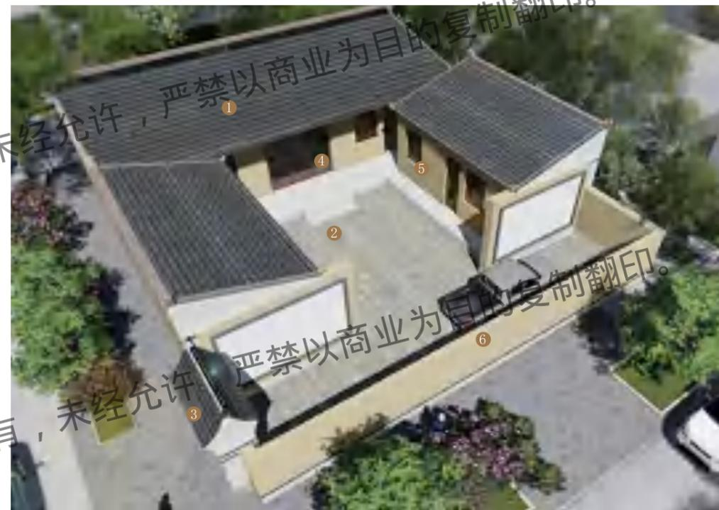
陇中片区方案一：采用传统四合院加前院的布局形式，主房为一层砖混结构单坡屋顶，墙面等采用当地常用建筑材料建造，达到建造经济，环保，以及使用安全的要求。
