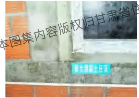
窗台混凝土压顶防水
