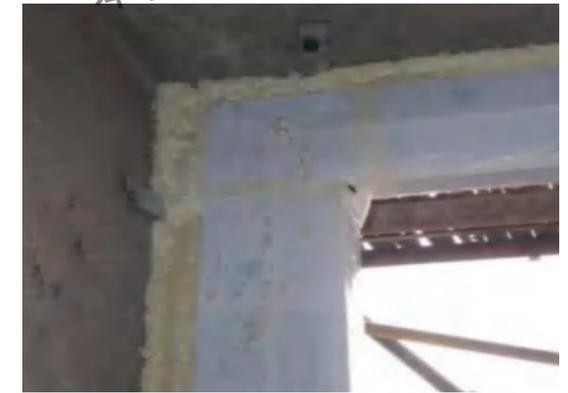
门窗框塞缝填密封胶
