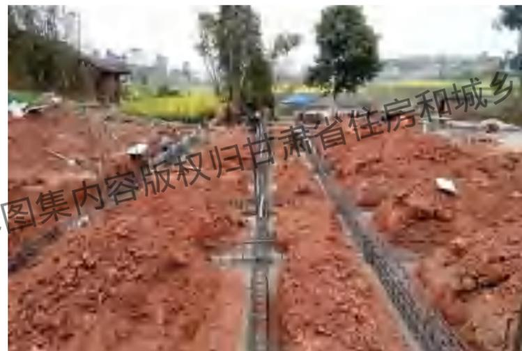
混凝土条形基础钢筋绑扎
