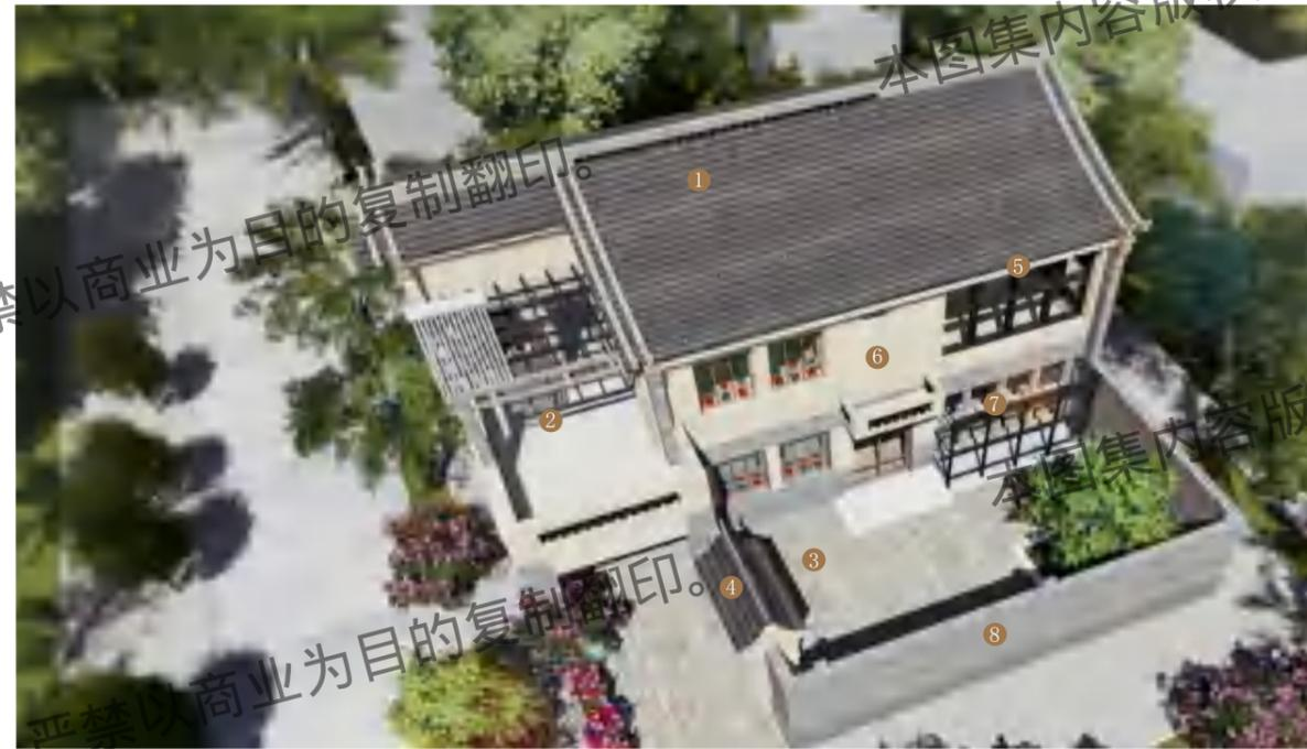
陇中片区方案：采用传统两层建筑形式及院落布局，符合中国传统建筑的两进合院模式，主房为两层砖混结构或框架结构，屋面为双坡屋顶且坡度较大，适合于雨水较多地区。两层形式为住户提供了更大的使用空间，充分体现了经济性、便利性的设计理念。
