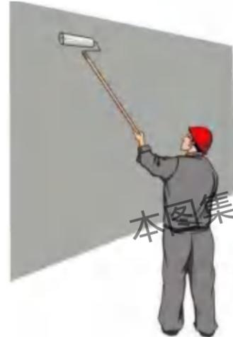
(2) 用不蘸取漆液的毛辊紧贴基层上下、左右来回滚动, 使漆液在基层上均匀展开。
