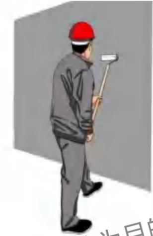
(1) 将蘸取漆液的毛辊先按 W 方式运动将涂料大致涂在基层上。
